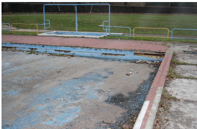
Obr.4 Zničená konstrukce bazénů
